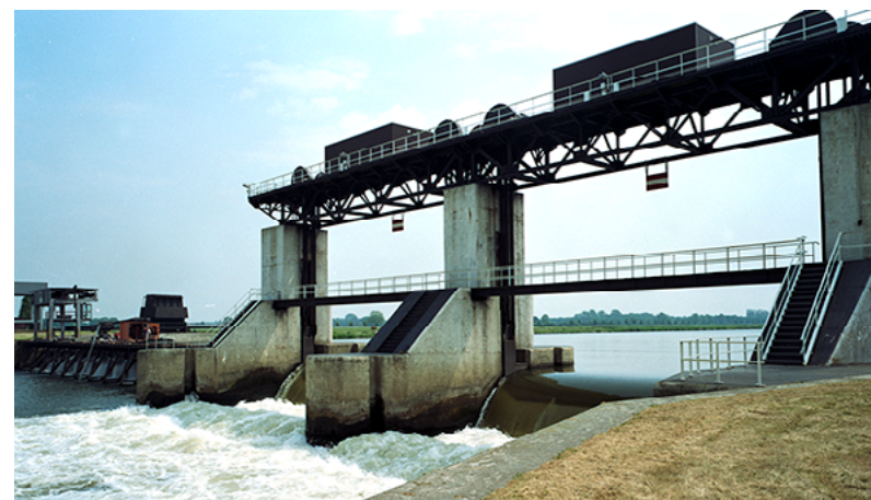
Figuur 2: Stuw bij Sambeek (bron: beeldbank Rijkswaterstaat).
